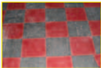
Revêtement de sol de type «FLOOR FLEX»
