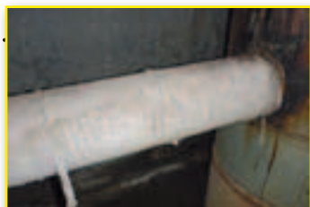
Enrobage de tuyaux
